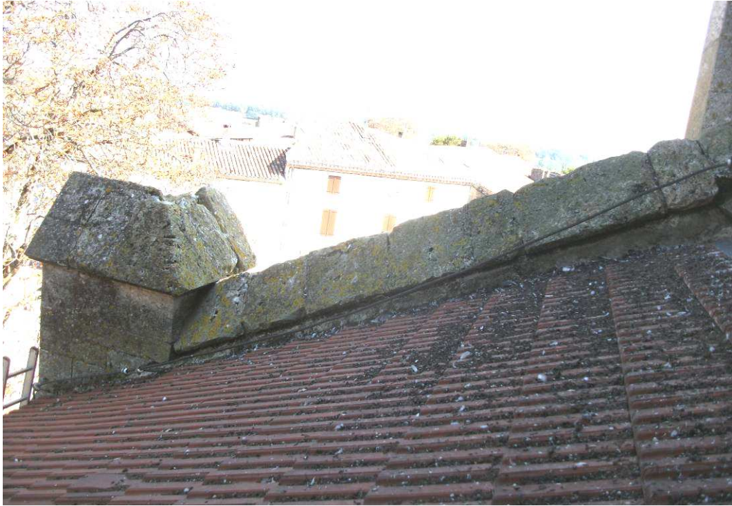
Chaperon rampant de pignon nord
