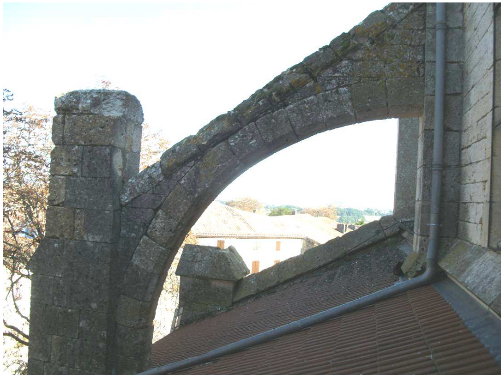
Arc-boutant n°1 face ouest
