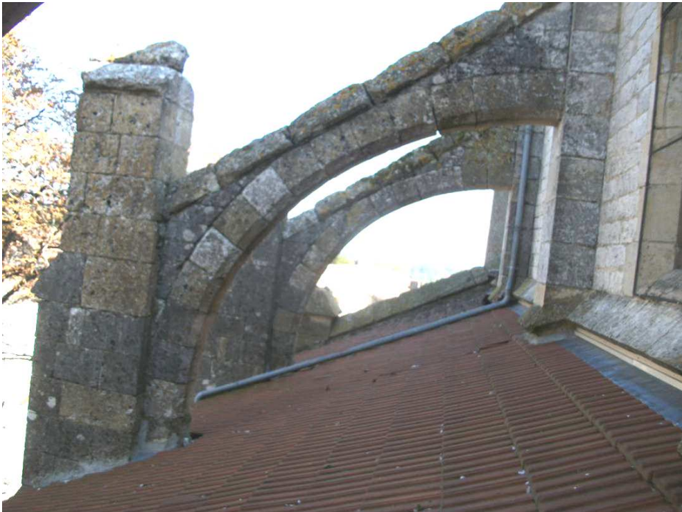
Arc-boutant n°2 face ouest
