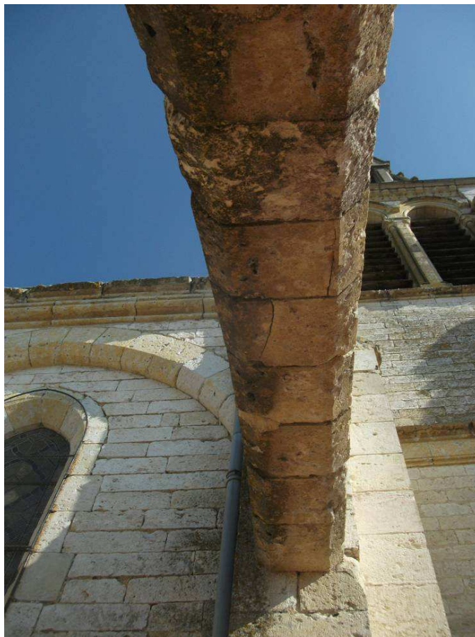
Sous-face d'arc-boutant n°1
