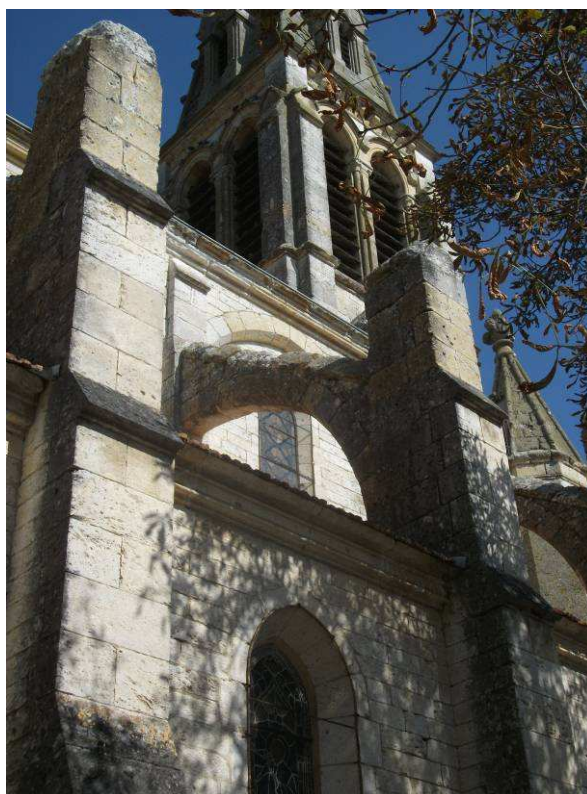
Arc-boutant n°2 face ouest
